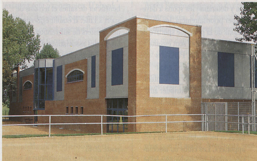
Le nouveau complexe F. Millet marie avec esthétique aluminium -brique -couleur. En plus des sports collectifs que l'on y pratique, une salle de musculation sera prochainement ouverte à l'étage, accessible aux personnes handicapées par un ascenseur.
