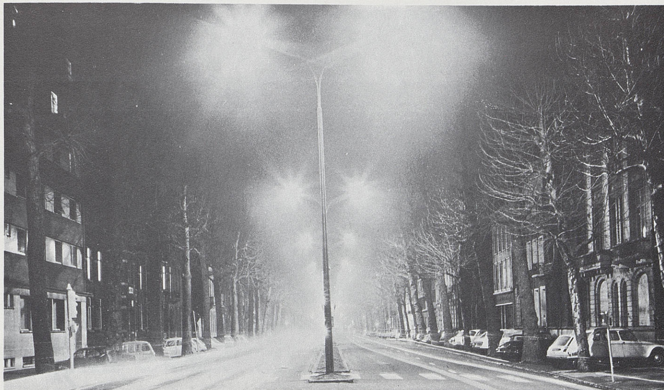
Boulevard Vauban : l'éclairage de cet axe routier est assuré par des candélabres situés sur le terre-plein central. Les lanternes sont équipées de sources modernes donnant un niveau d'éclairage élevé.
