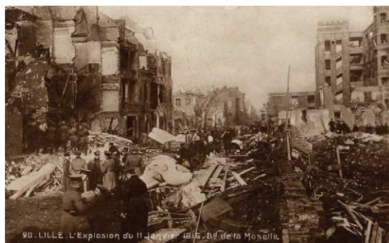
7F1542 « Vue des ruines du Boulevard de la Moselle suite à l'explosion du dépôt de munitions des 18 ponts, le 11 janvier 1916 »
