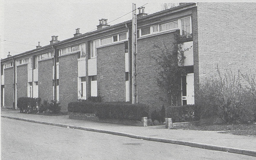
« Un grand programme de petits travaux » : de petits immeubles rénovés ou construits par les offices H.L.M.
