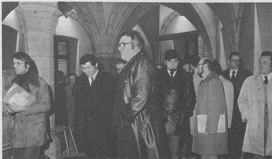
■ Le 3 janvier, M. Pierre Mauroy visitait les chantiers en cours dans la cité... ici, au Palais Ribour,...
