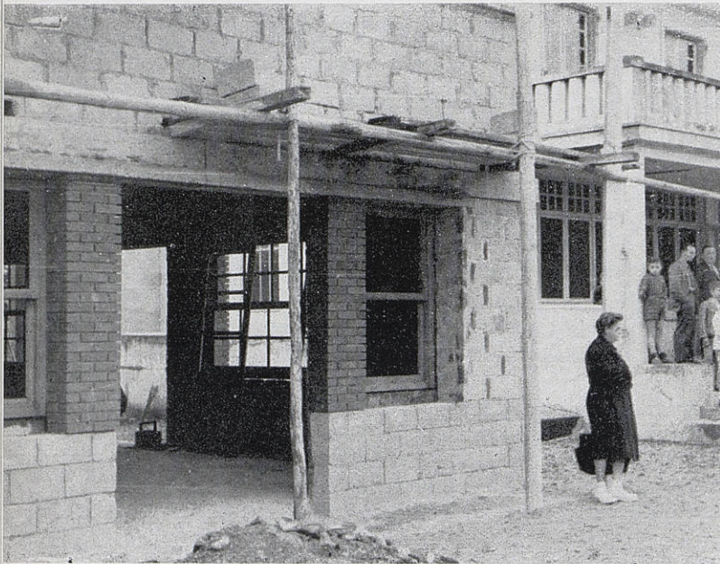
Colonie de BRIGHTON. Travaux en cours. Entrée de la salle de jeux.
