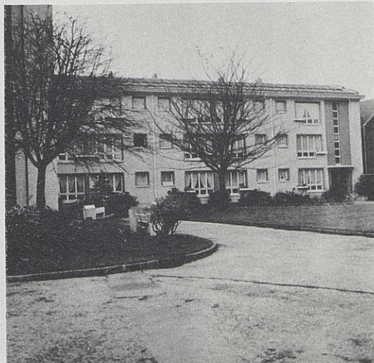
Logements de la rue Van Hende
