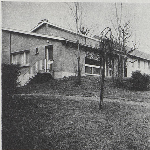
Le centre de soins (vue extérieure)
