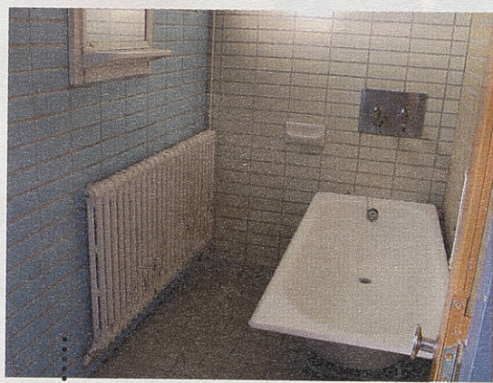
Un projet de rénovation des bains-douches est actuellement à l'étude.
