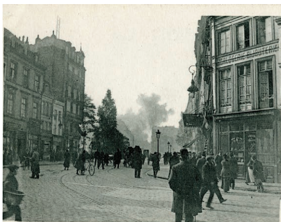
7FI560 « Vue sur la rue Inkermann suite à l'explosion d'une bombe sur l'Hôtel de Bretagne, le 9 octobre 1914. »
