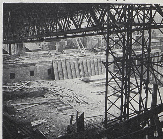
Le chantier de la Piscine Olympique
