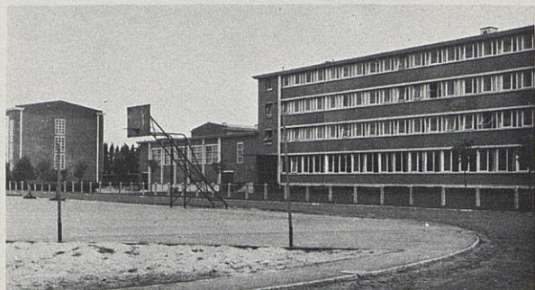
132 bâtiments scolaires Des lycées modernes avec terrains de sports
