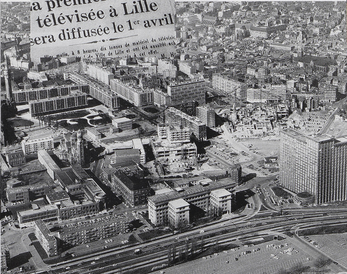
Le nouveau quartier Saint-Sauveur, en construction. La Cité administrative, les CCP, la Trésorerie générale et le chantier du Forum, en 1972.
