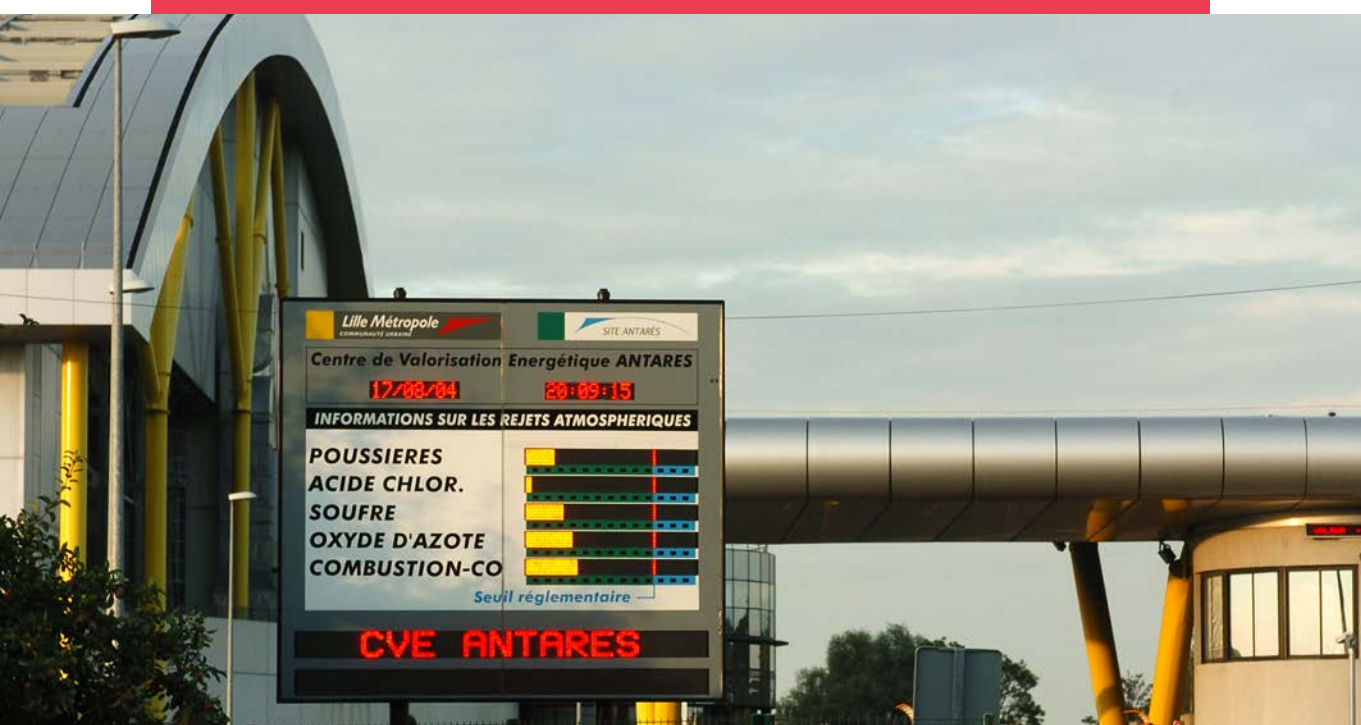
Le centre de valorisation énergétique
