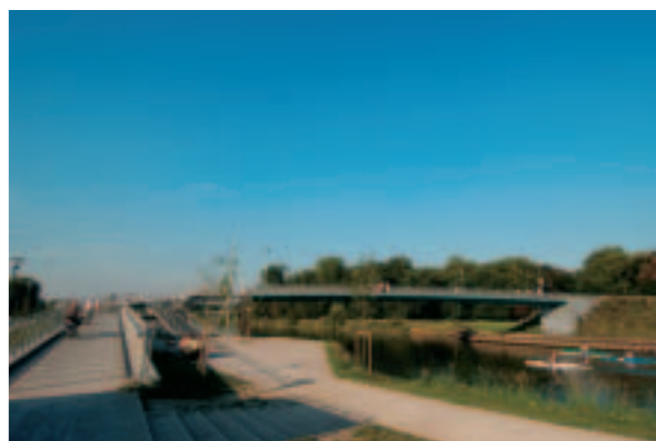
L'un des derniers aménagements réalisés par la municipalité : la passerelle Soubise, accessible aux piétons, cyclistes, poussettes, fauteuils roulants...
