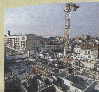
... 130 logements sont en cours de construction rue de Flandre.
