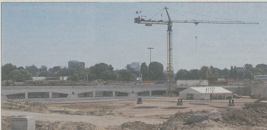
La gare « Lille-Europe » en construction.
