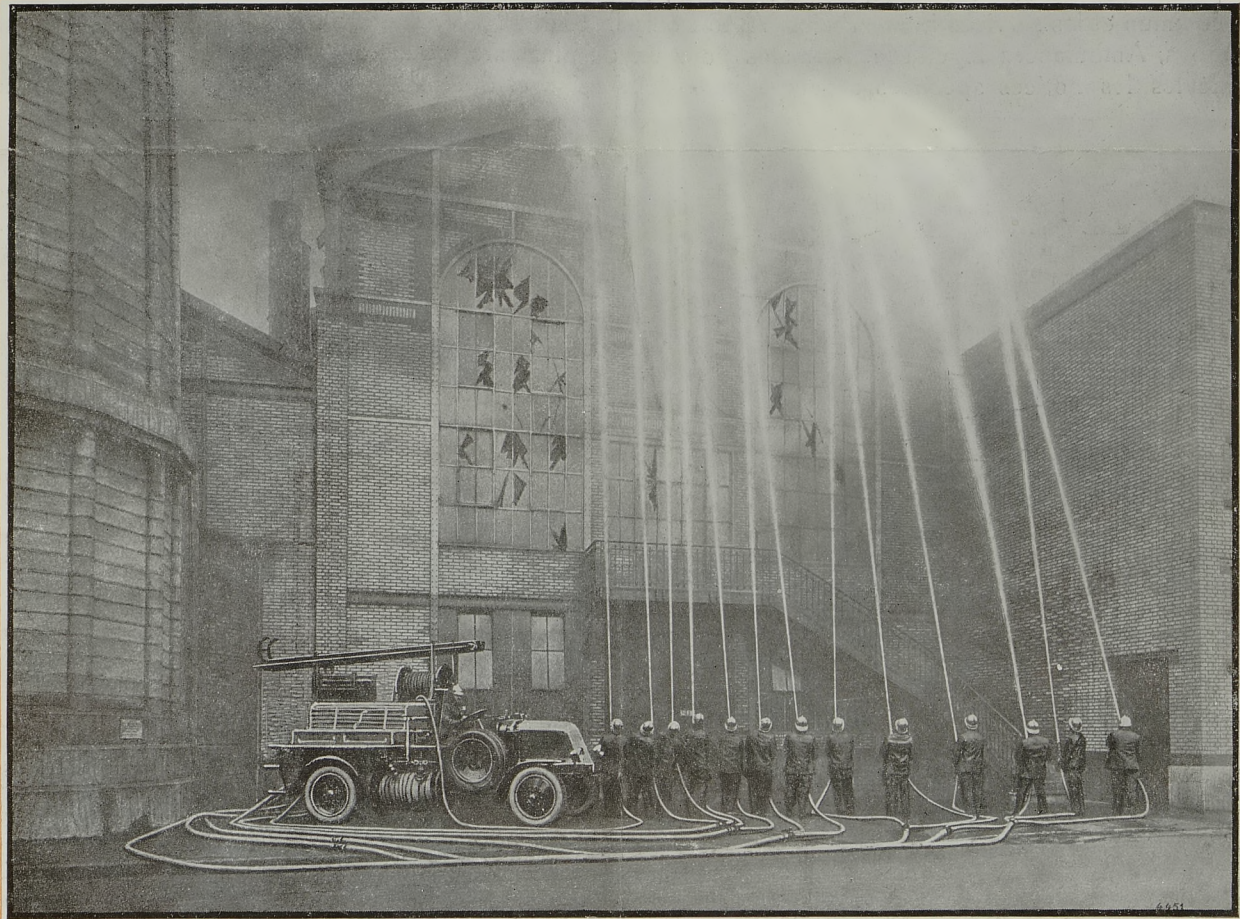
FOURGON POMPE À INCENDIE DE PREMIER SECOURS EN ACTION
