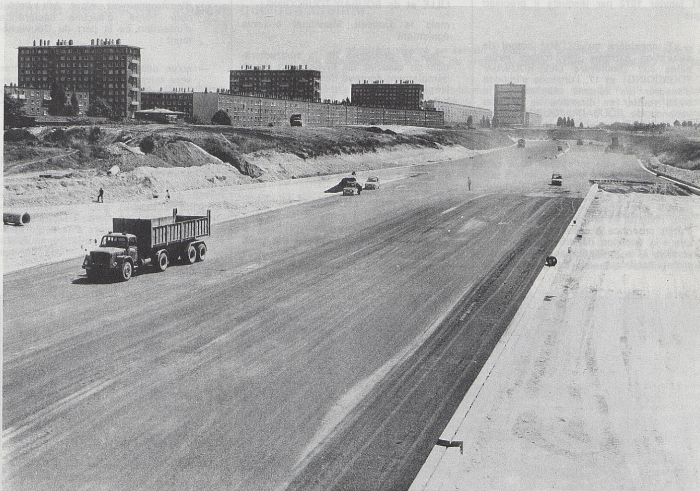
Développer l'accessibilité de Lille : Le chantier du futur boulevard périphérique.
