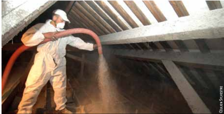
Isolation par projection de ouate de cellulose.
