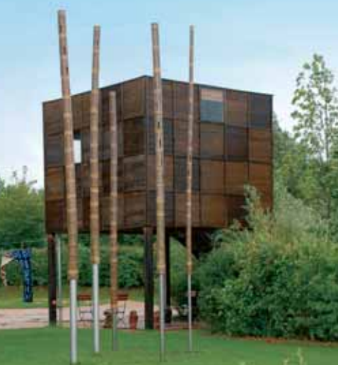
La case construite sur pilotis de l'île Africa Mama.
