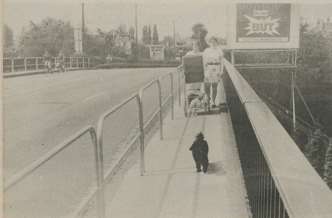
Glissières de sécurité posées sur le pont de Lezennes
