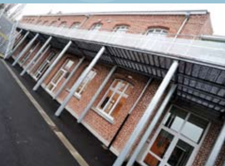
Le bâtiment du XIX e siècle a été métamorphosé en bâtiment du XXI e !
