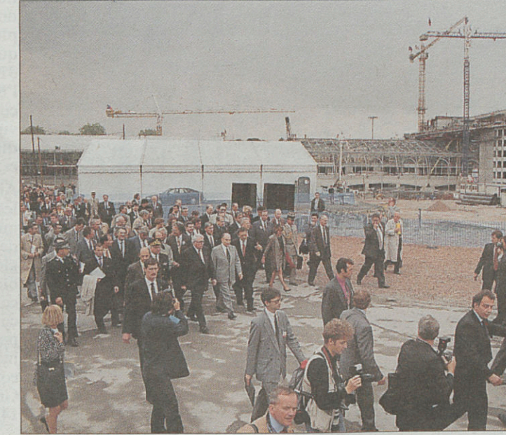
François Mitterrand sur le chantier d'Euralille, la « turbine tertiaire » qui créera, bientôt, 5 000 emplois.
