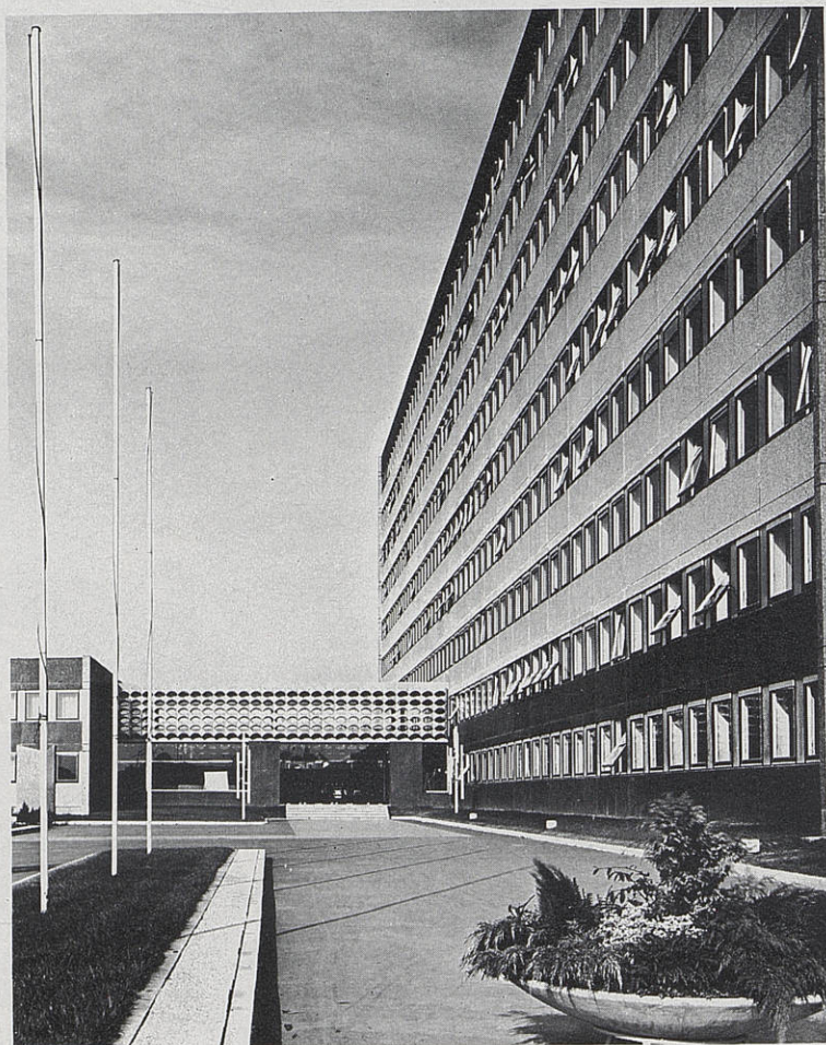
L'Hôtel de la Communauté Urbaine au carrefour des voies de communication régionales
