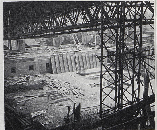
Le chantier de la Piscine Olympique
