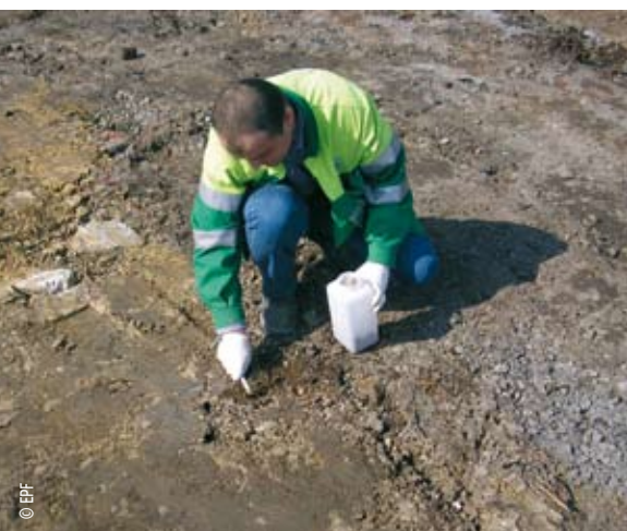
Le sol est régulièrement analysé au fur et à mesure qu'on enlève les terres.
