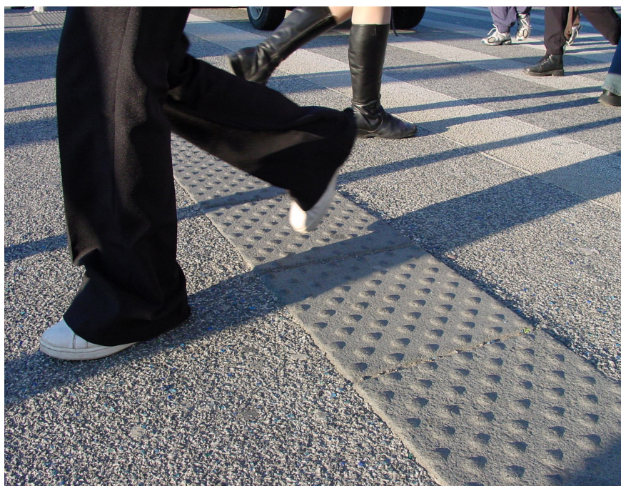
Aménagement des traversées piétonnes
