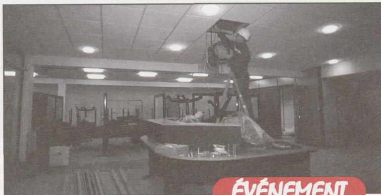
Derniers travaux, juste avant l'ouverture le 15 décembre
