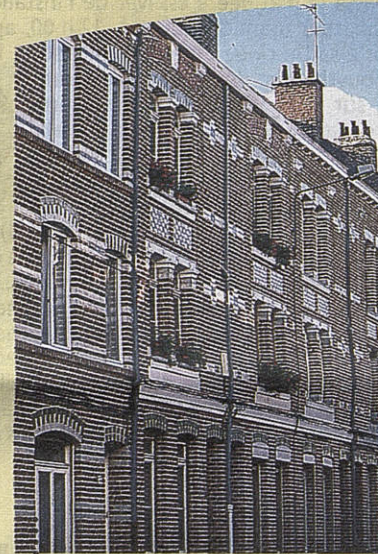
La rue du Docteur Yersin a été une « bonne » rue puisque 18 des 44 façades y ont été ravalées.
