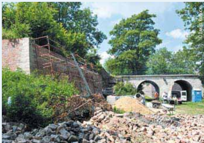
Voilà une quinzaine d'années que se succèdent les chantiers d'insertion pour une remise en beauté et en sécurité des remparts de la Porte de Gand.
