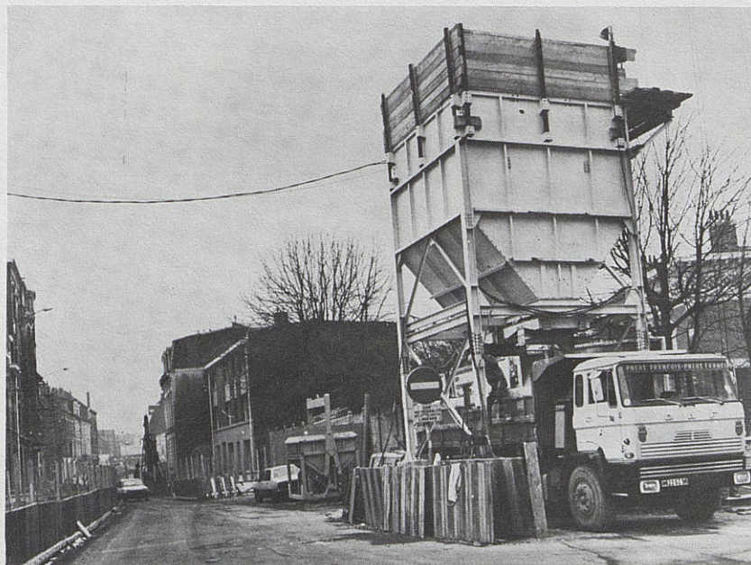
Les travaux du métro dans le secteur de Fives.
