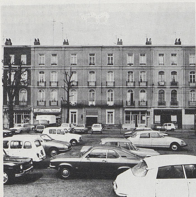
Un exemple réussi de ravalement de façades : la place Vanhoenacker.
