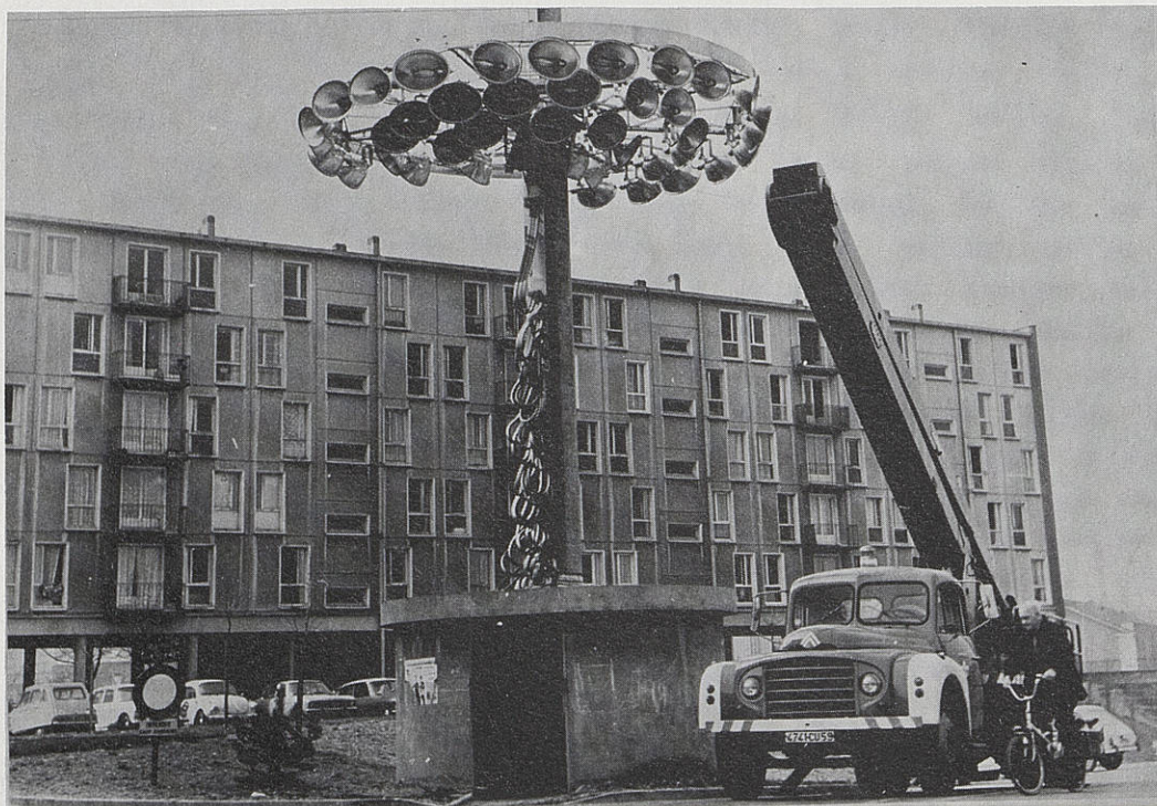
Un système de palan électrique permet l'entretien des sources lumineuses éclairant les abords des autoponts lillois.
