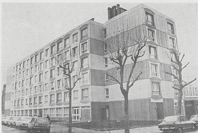
Nouvelle résidence pour personne âgées de la rue de Toul.
