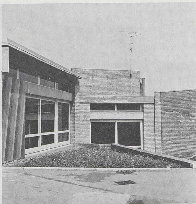
L'école Croisette en cours de construction
