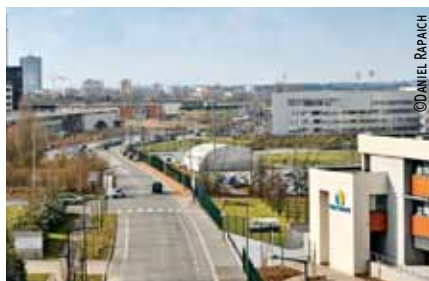
Le parc Eurasanté est situé sur le vaste campus du centre hospitalier régional universitaire.
