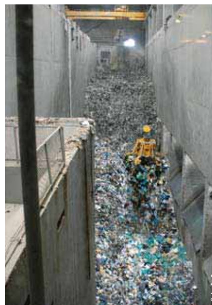
La fosse où sont stockés les déchets avant d'être incinérés est impressionnante. Percée de 18 portes, elle peut contenir 13 000 m 3 de déchets.
